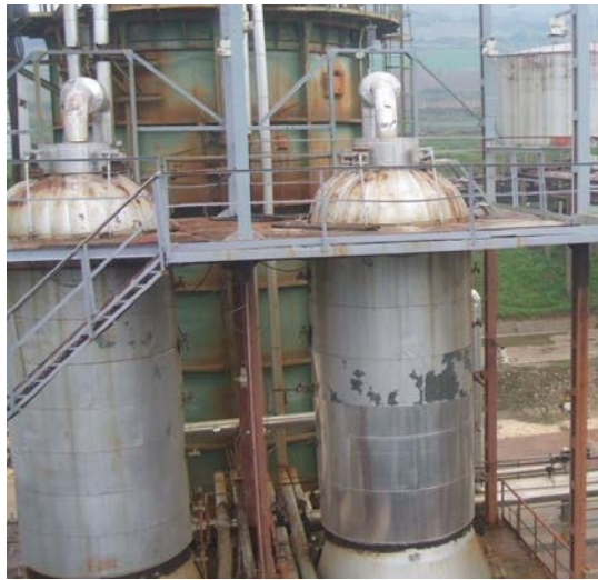
Figura 1: Skema teknologjike egzistuese e hidropastrimit të produkteve të bardha të naftës në KPTHN, Ballsh me dy reaktor.
